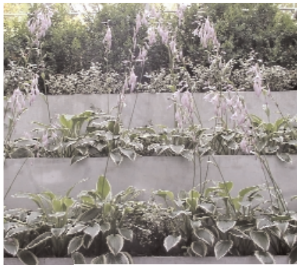
Terrassierung einer Böschung mit verzinktem Flachstahl, farblich abgestimmt mit silbrigweiß panaschierten Hosta und ihren hellvioletten Blüten
